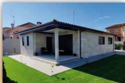
Viviendas de obra y prefabricadas
